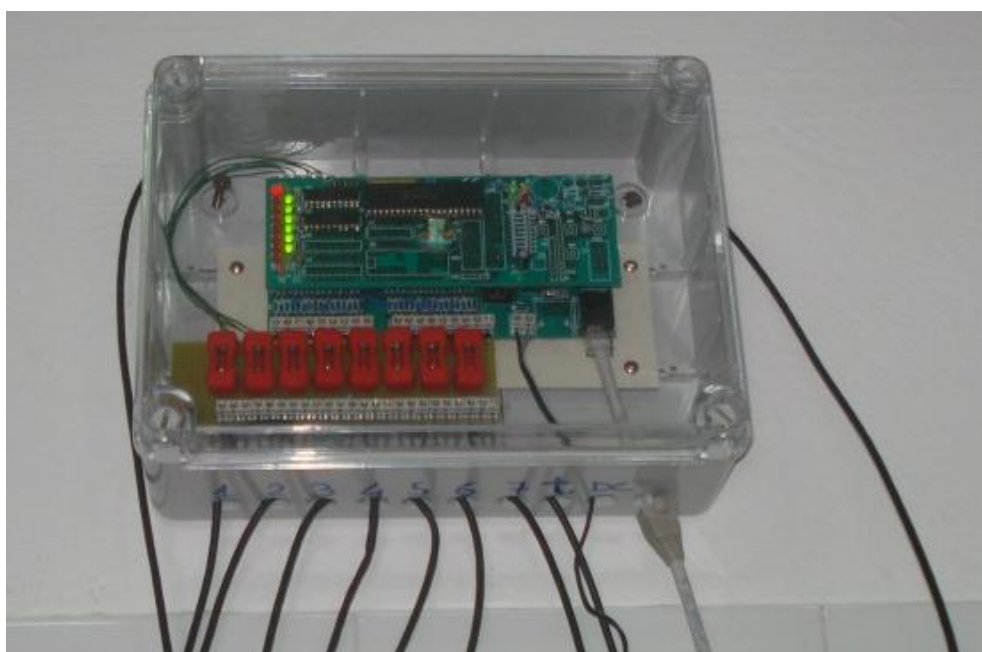
Figura 11: Hardware di controllo . I led indicano l'apertura (verde) o la chiusura delle valve (rosso). Entrambi i led spenti indicano lo zero, dal quale far partire la registrazione.
