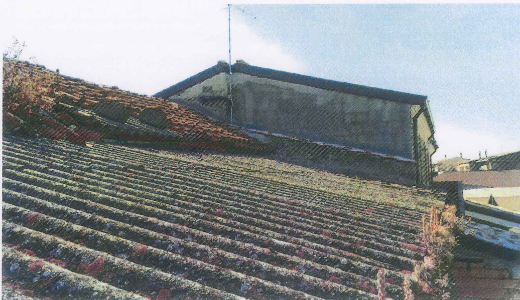
Fig. 3 – Particolare copertura in cemento amianto.
