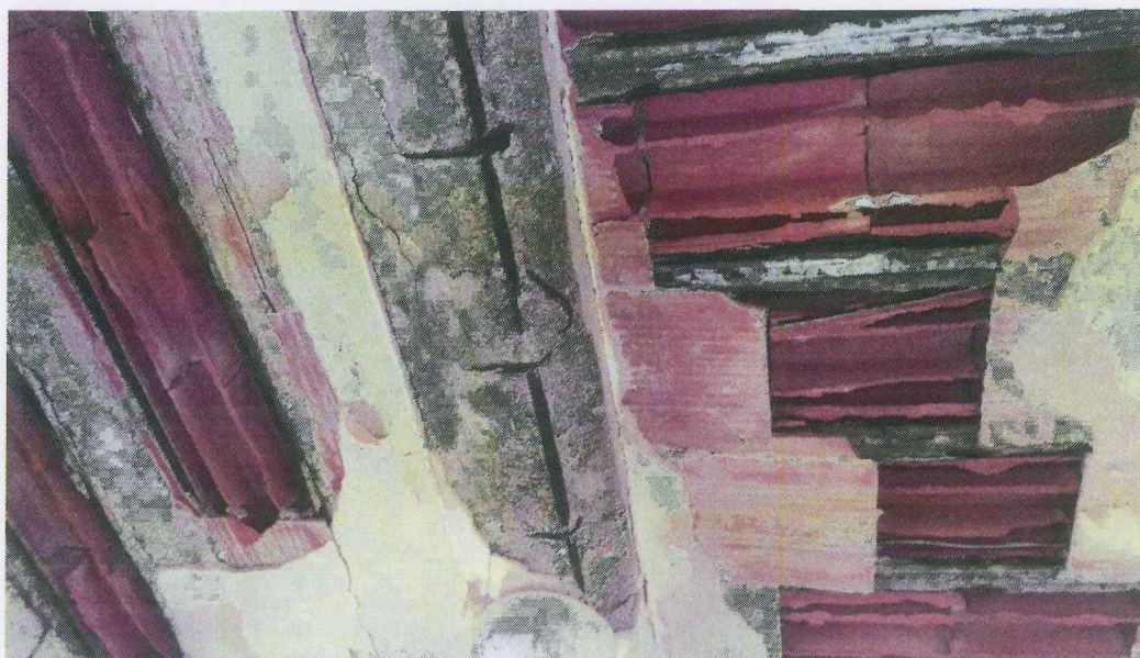
Fig. 8/9 – Fenomeni di degrado statico dell'impalcato e della struttura portante.
